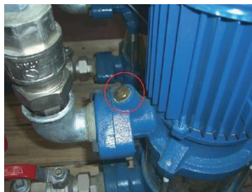
Obrázek 8: Montáž snímače tlaku na otvor ventilace vzduchu na výtlačném čerpadle.
